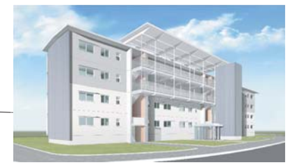
エレベーター、廊下を設置したリニューアル住棟
